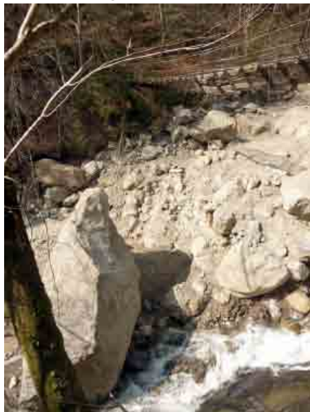
Gros blocs transportés par la lave torrentielle et pont suspendu endommagé dans le Sundgraben
